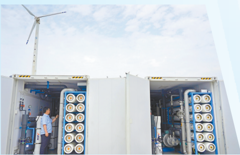
6月7日，工作人员在对海水淡化集装箱进行调试。 新华社记者 万象 摄
