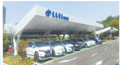
东台市行政中心2024年新增新能源充电桩车位48个(超充8个,快充40个),均采用华为全液冷超充设备。
