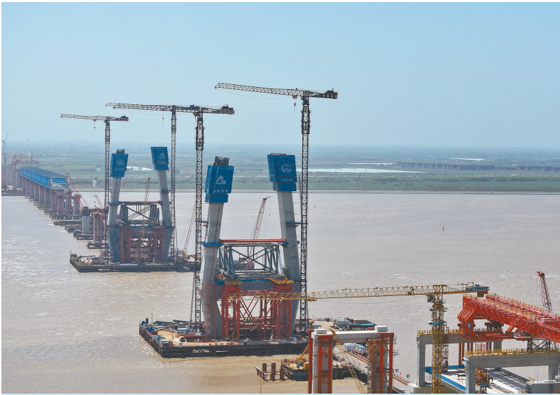
4月13日拍摄的崇启公铁长江大桥4号主塔(中)第17节浇筑施工现场(无人机照片)。当日,由中铁大桥局承建的崇启公铁长江大桥4号主塔第17节浇筑完成,塔身高度突破100米,大桥进入上塔柱施工阶段。 崇启公铁长江大桥是沪渝蓉高速铁路全线重点控制性工程,大桥全长4.09公里,横跨长江北支,是江苏启东与上海崇明的主要连接通道。 新华社 发(许丛军 摄)
