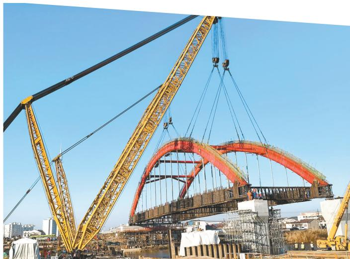
1月16日上午9时,随着劲性骨架系杆拱桥稳稳地落在桥墩支座上,历时两个小时,响水双园大桥西跨系杆拱桥整体吊装圆满完成。
