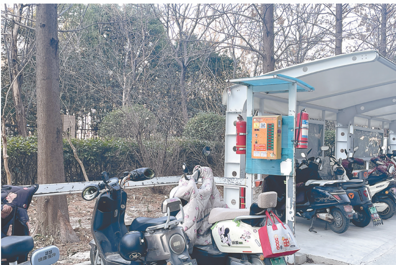
电动自行车充电站配备相应灭火设备
