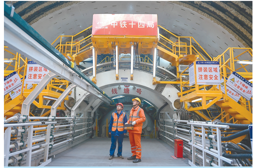
1月12日,中铁十四局技术人员在钱塘江隧道“钱塘号”盾构机内作业。当日,在浙江宁波市周王庙镇施工现场,新建杭州萧山机场站枢纽及接线工程钱塘江隧道“钱塘号”盾构机顺利启动,标志着杭州机场高铁下穿钱塘江隧道工程建设取得新进展。 新华社记者 黄宗治 摄
