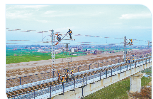
滨海铁路电气化
