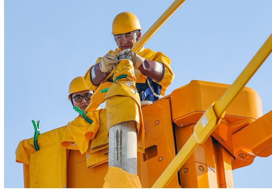
近日，在亭湖区青墩镇，供电部门电力工人对10kV红升线进行带电立杆，新增一台变压器。在夏季用电负荷高峰期间，为确保电力供应平稳有序，市供电公司加大对设备的检修工作，积极采取停电作业配合的方式，尽可能缩小停电范围，形成“用户零感知”的检修模式。
