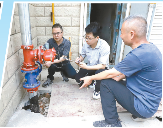
大丰区审计局聚焦小区消防设施维修项目,组织审计力量对小区使用维修资金更新、维修消防设施等情况进行现场勘察,助力提升维修资金在守护小区消防安全中的作用。
