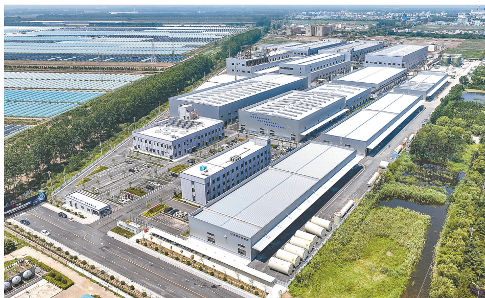
江苏天能新材料有限公司 记者 王焱 摄
