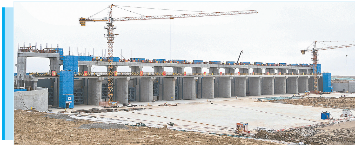
新洋港闸下移工程主体于2023年4月18日开工建设，目前，新闸水下主体工程基本完成，累计完成投资10.8亿元，预计2025年10月全部完工。这是4月16日上午，工程现场的施工场景。 记者 李思远 摄
