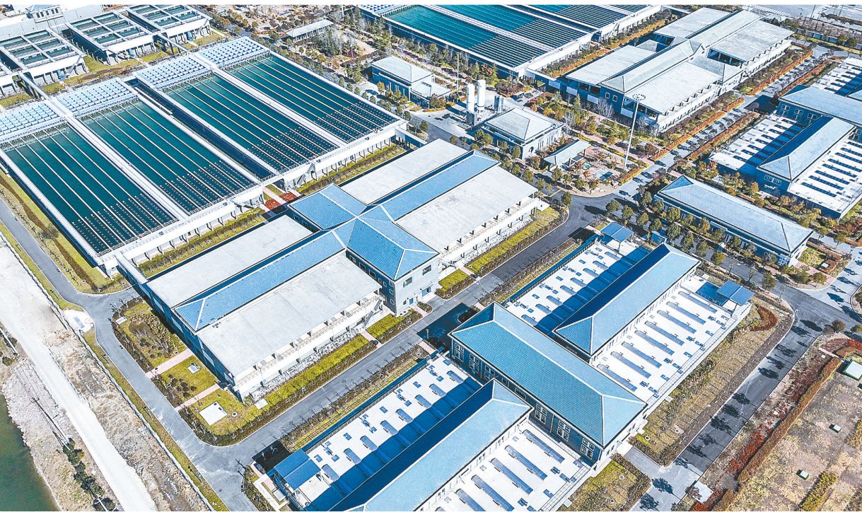
盐龙湖水厂二期总建筑面积7039.42平方米，采用“预处理+常规处理+深度处理”和“高效浓缩+机械脱水”的处理工艺，日处理生活用水量达60万吨，有力保障大市区及周边县(市)200多万人口的供水需求。 记者 王焱 摄
