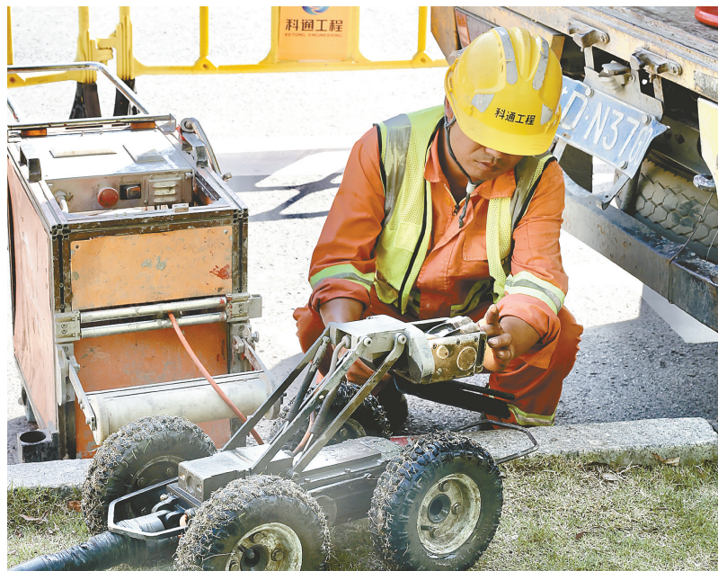
正值汛期，地下管网畅通事关城市安全度汛。7月5日下午，在盐南高新区新园路聚亨路口，博铭维技术旗下科通工程施工团队熟练操作Dolphin-L2管网检测机器人，对市政排水系统管道进行内窥检测疏通工作。 见习记者 张雨桐 吴寅 摄
