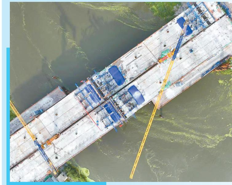
5月25日，随着右幅悬臂现浇梁浇筑完成，中铁五局承建的国道204盐阜快速通道黄沙港特大桥连续梁顺利合龙，为全线顺利通车奠定坚实基础。国道204盐阜快速通道全长41.4公里，是国家“五纵”交通干线中沿海通道的重要组成部分，按双向六车道一级公路标准建设，设计时速100公里，计划于2023年建成通车。
