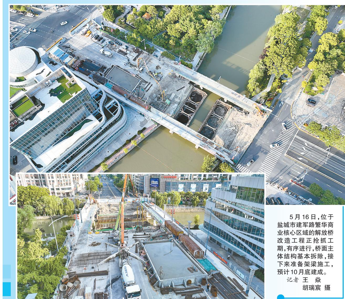
5月16日，位于盐城市建军路繁华商业核心区域的解放桥改造工程正抢抓工期，有序进行，桥面主体结构基本拆除，接下来准备架梁施工，预计10月底建成。
