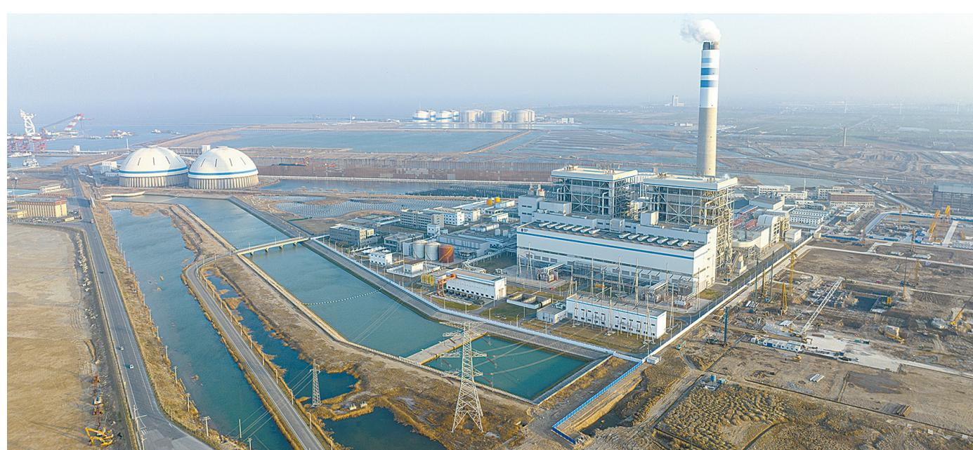
国家电投集团协鑫滨海发电有限公司一期工程2×1000MW超超临界燃煤发电项目,配套建设10万吨级航道和码头、储配煤中心等重要设施,最大储煤量超过100万吨。该项目采用多项先进技术,污染物排放优于国家超低排放要求,先后获得电力行业优质工程奖、中国安装工程优质奖及其他省部级奖项40余项,并于2019年11月荣获“国家优质工程金奖”,环保示范引领贡献巨大。
