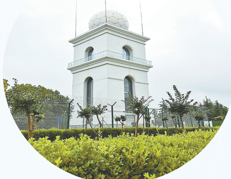
位于盐城南洋国际机场的新一代多普勒天气雷达,实现了24小时全天候观测。
