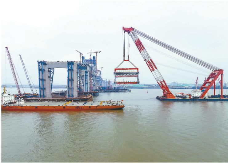
3月20日,中交二航局建设者在常泰长江大桥主航道桥泰州侧施工现场进行首节段钢桁梁架设(无人机照片)。
