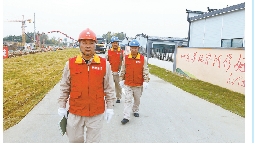
10月31日下午,国网滨海供电公司工作人员来到淮河入海水道二期工程张家河闸站工程施工现场,检查电气设备,排查缺陷隐患,保障施工现场安全可靠用电。 周吉成 摄
