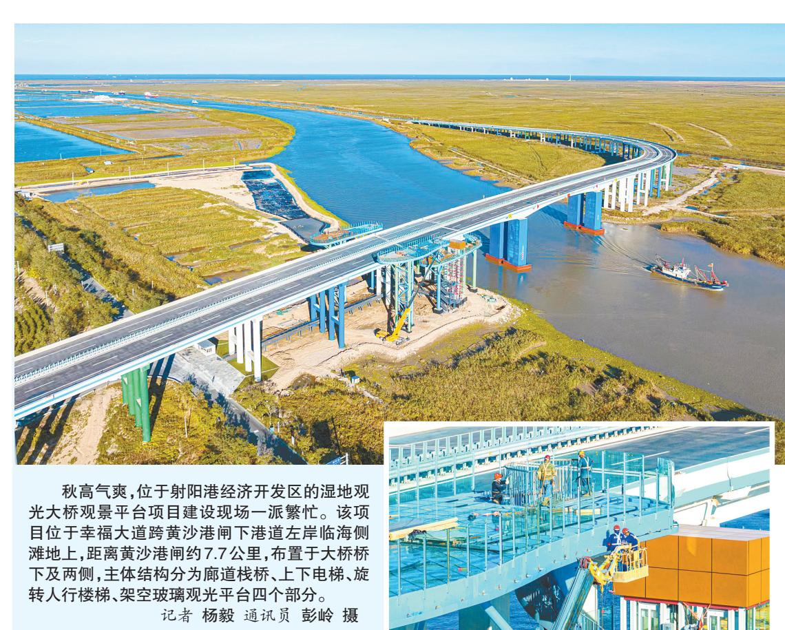
秋高气爽,位于射阳港经济开发区的湿地观光大桥项目建设现场一派繁忙。该项目位于幸福大道跨黄沙港闸下港道左岸临海侧滩地上,距离黄沙港闸约7.7公里,布置于大桥桥下及两侧,主体结构分为廊道栈桥、上下电梯、旋转人行楼梯、架空玻璃观光平台四个部分。
