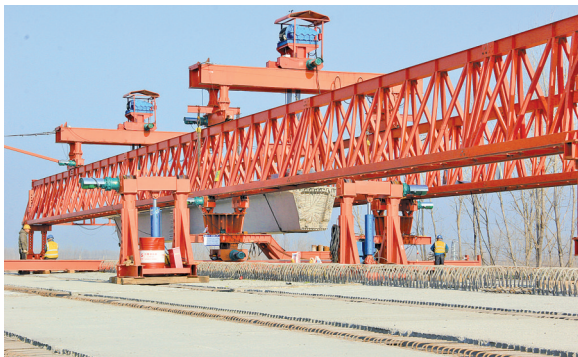
预制盖梁安装 徐铁 摄
