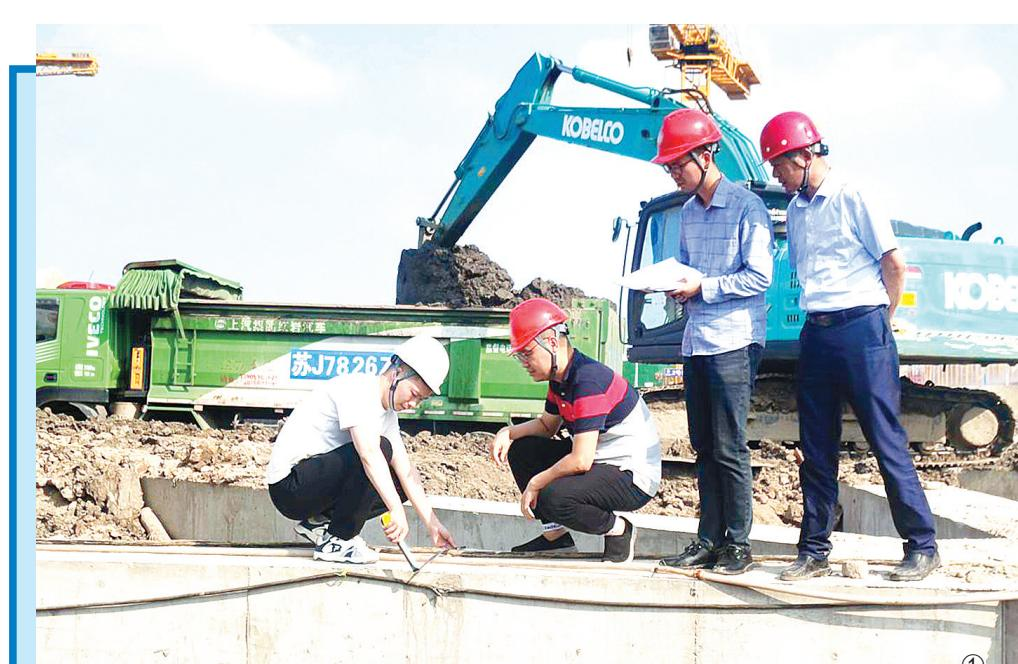
图①：市审计局派出审计组对市第二人民医院改扩建工程进行全过程跟踪审计。审计组紧跟工程进度，及时抽测场地标高、钢筋型号、桩基规格、围护桩间距等，将审计关注点渗透到各个建设细节，不留盲区，切实督促民生工程在源头上规范建设。
